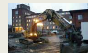
Gravemaskinene er i gang på Meteorologisk institutt på Blindern
