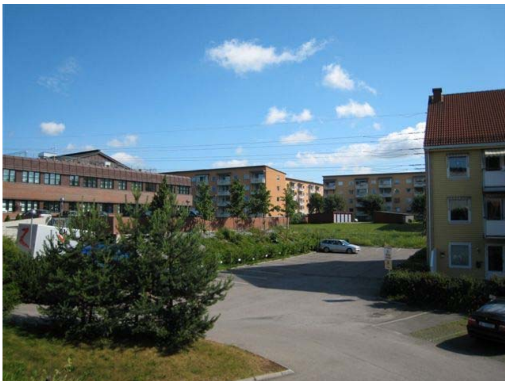
Ryenstubben 2 og 6 ( eksisterende situasjon) sett fra syd-vest
