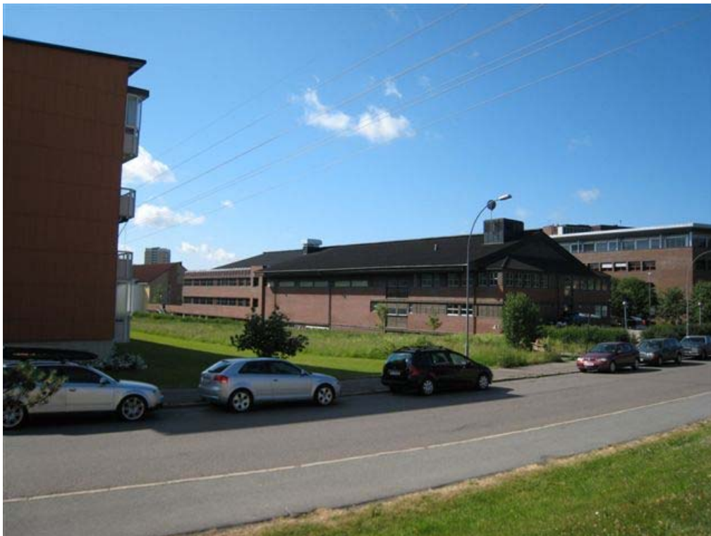
Ryenstubben 2 (eksisterende situasjon) sett fra nord.
