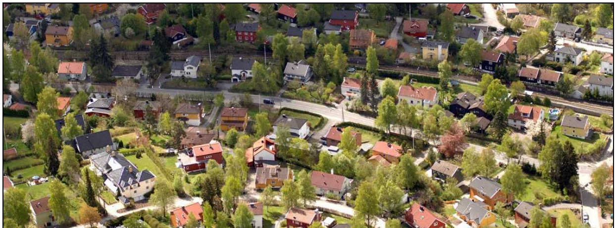
Figur 2 Landskapet langs Griniveien (Oslo kommune 2006).
